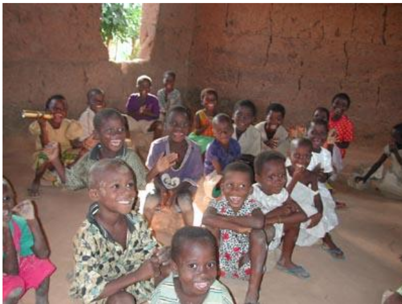
Une salle de classe avant les travaux et l'arrivée des tables-bancs. Les élèves du primaire étaient assis sur une pierre en guise de siège.
